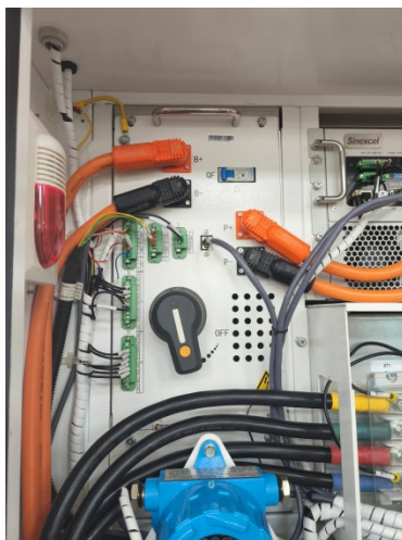
附图 6-36 拆除线缆
