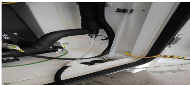
附图 6-4 液冷管路底部排液口示意
