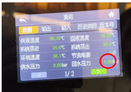
附图 6-15 排气完成示意
