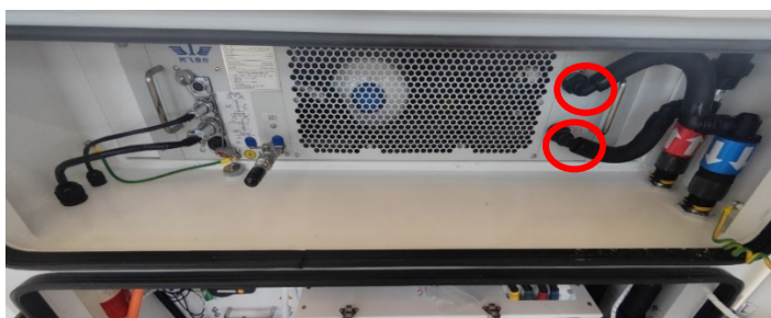
附图 6-7 液冷机进、出水管拔除示意
